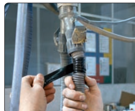
Abdichten eines Lackierschlauches
